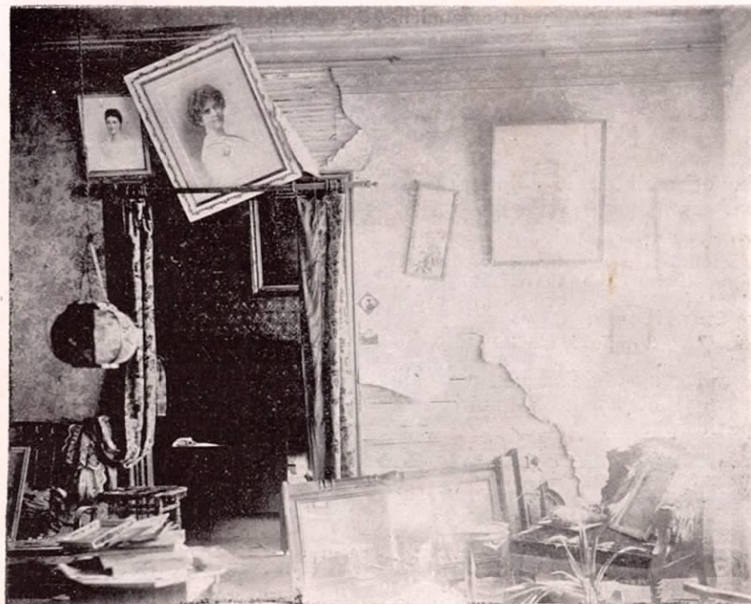
Interior de una habitación después del temblor del 13 de los corrientes
